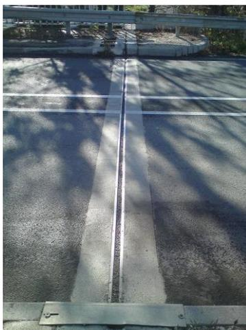
**Imagen 5: Juntas de dilatación de un puente.** Fuente:
