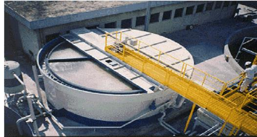
Tanque de separador por flotación
