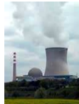
Torres de refrigeración de una central nuclear.
